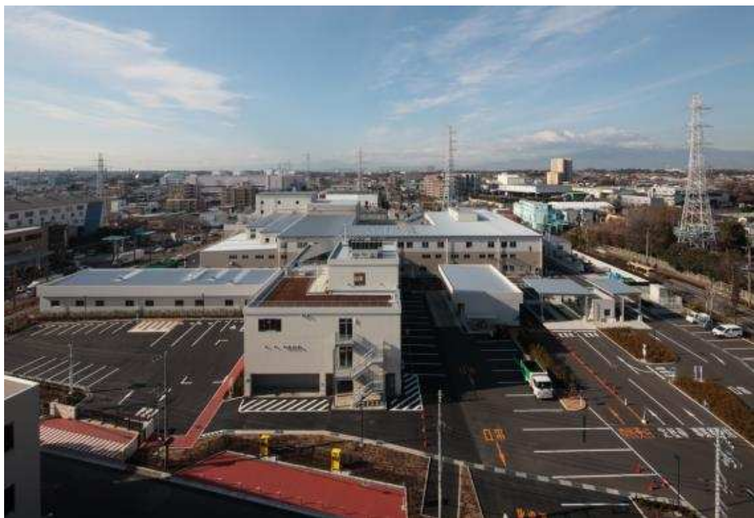
【リサイクルプラザ藤沢（全体）】
