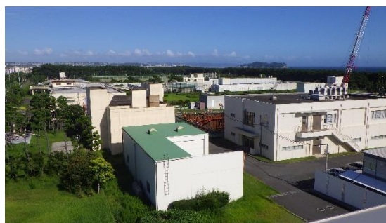
【辻堂浄化センター】
