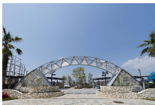
（写真）Fujisawa SST 協議会提供 【正門】
