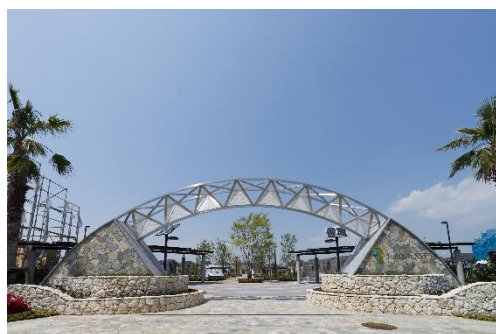
(写真) Fujisawa SST 協議会提供 【正門】
