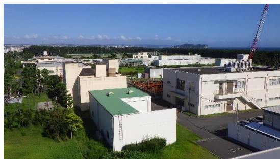
【辻堂浄化センター】
