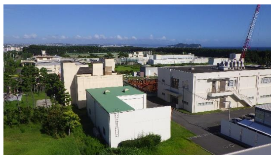
【辻堂浄化センター】
