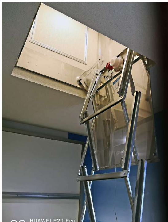
ベランダから下へ避難するハシゴと蹴破る隔て板
