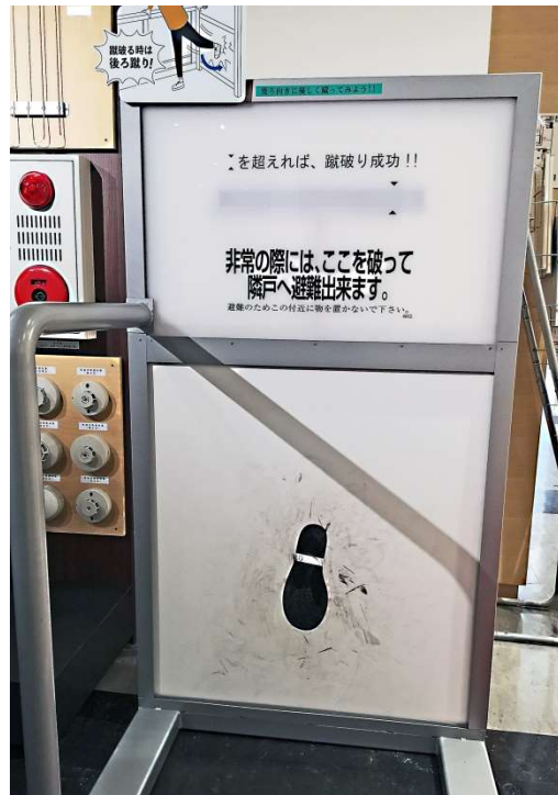
ベランダから下へ避難するハシゴと蹴破る隔て板
