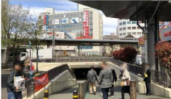
現況は、地下通路への動線としてスロープが整備されているものの、バリアフリー動線が確保されていないことや歩行者と自転車が混在している。本計画では、地下レベル及び地上レベルをつなぐ歩行者通路（エレベーター・エスカレーター）を整備し、バリアフリー動線を確保するとともに、駅前広場内に自転車スロープを整備することで、動線の分離を図り、安全な広場空間を確保。
