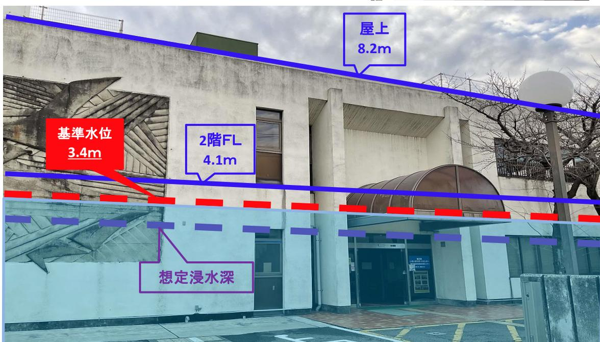
イ 本館は、平成27年の耐震補強工事にあわせて津波避難用の鉄骨屋外階段と屋上フェンスが整備された。屋上の有効面積は、557㎡で約920人が上ることができるスペースであるが、当該建物設計時の上載限度重量計算では約270人であり、過剰な屋上避難はリスクが高い。
