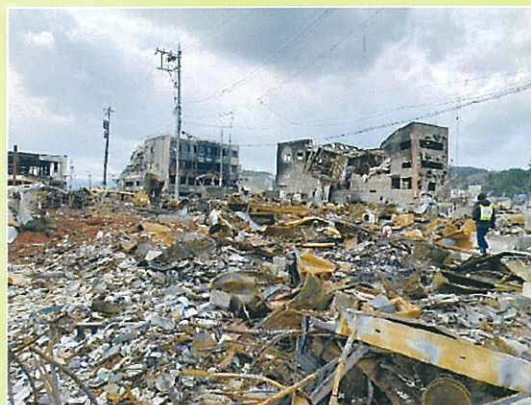
能登半島地震で倒壊した家屋
