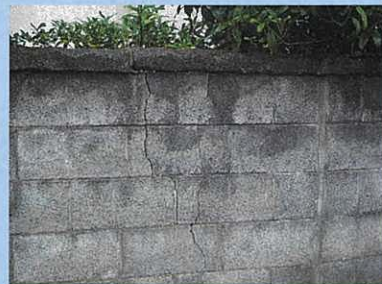
ブロック塀の状況
