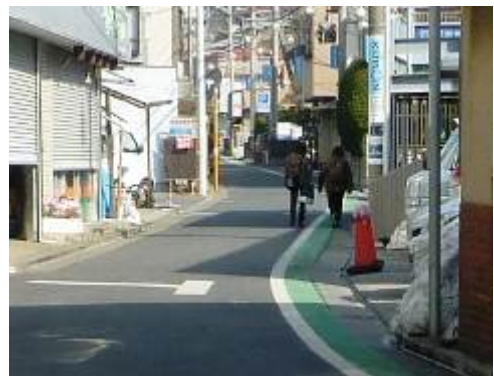
設置したグリーンベルト
