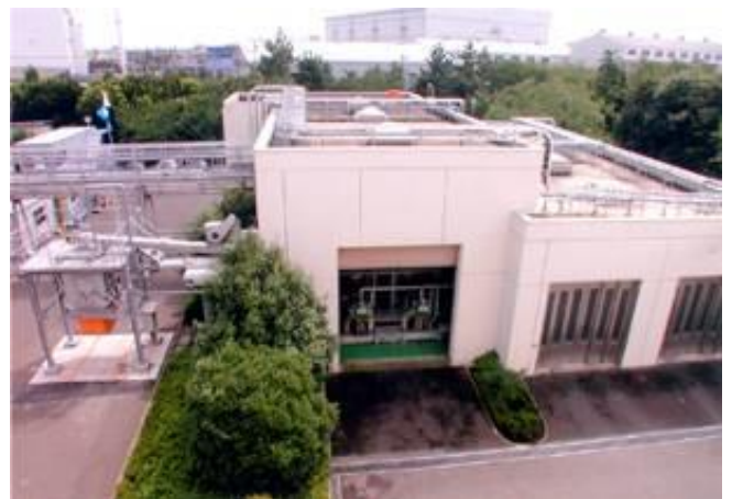
受入棟（前処理施設）
