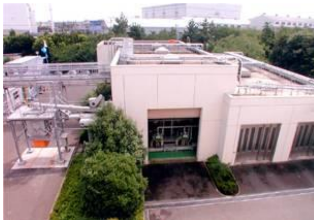
受入棟（前処理施設）
