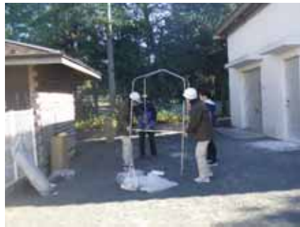
▲埋設型トイレ設置訓練
