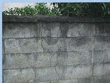
ブロック塀の状況
