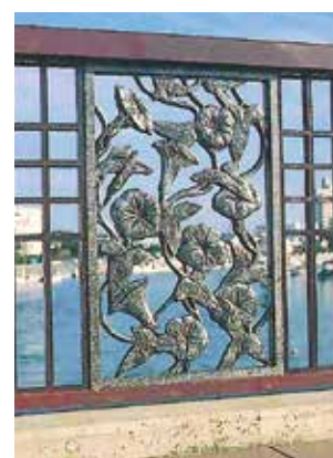
図 7-2. 山本橋の高欄
