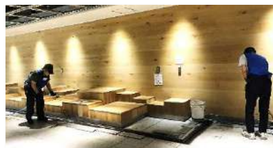
北口地下広場側溝の水洗い
