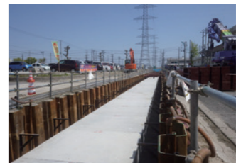
地盤沈下による浸水被害の解消を目的とした明月雨水幹線整備工事。
