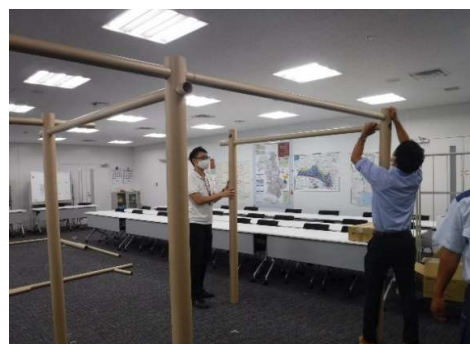
5 組立 （2区画目を設営する）
