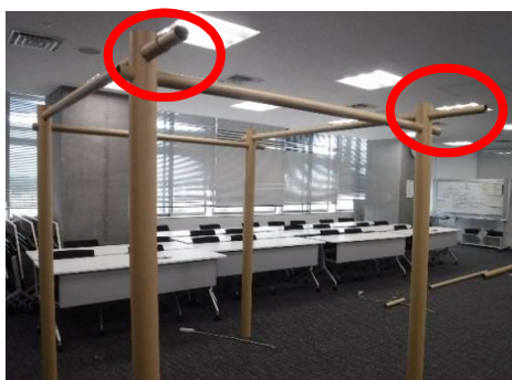
4 1区画完成 （延長用紙管取付）
