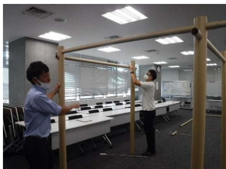
3 組立 （初めに1区画を設営する）
