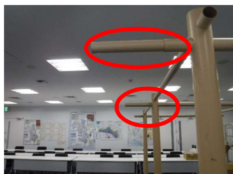
2 2区画設営 （延長用紙管取付）
