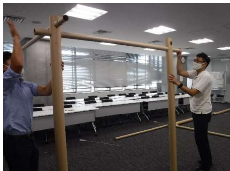
2 組立 （初めに1区画を設営する）
