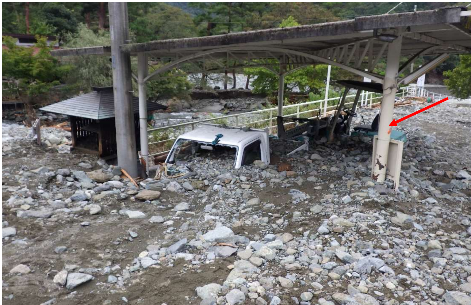
相模原市緑区青根 此ノ間沢 (10月12日7時20分 土砂災害警戒情報発表) 土砂災害警戒区域(土石流)内
